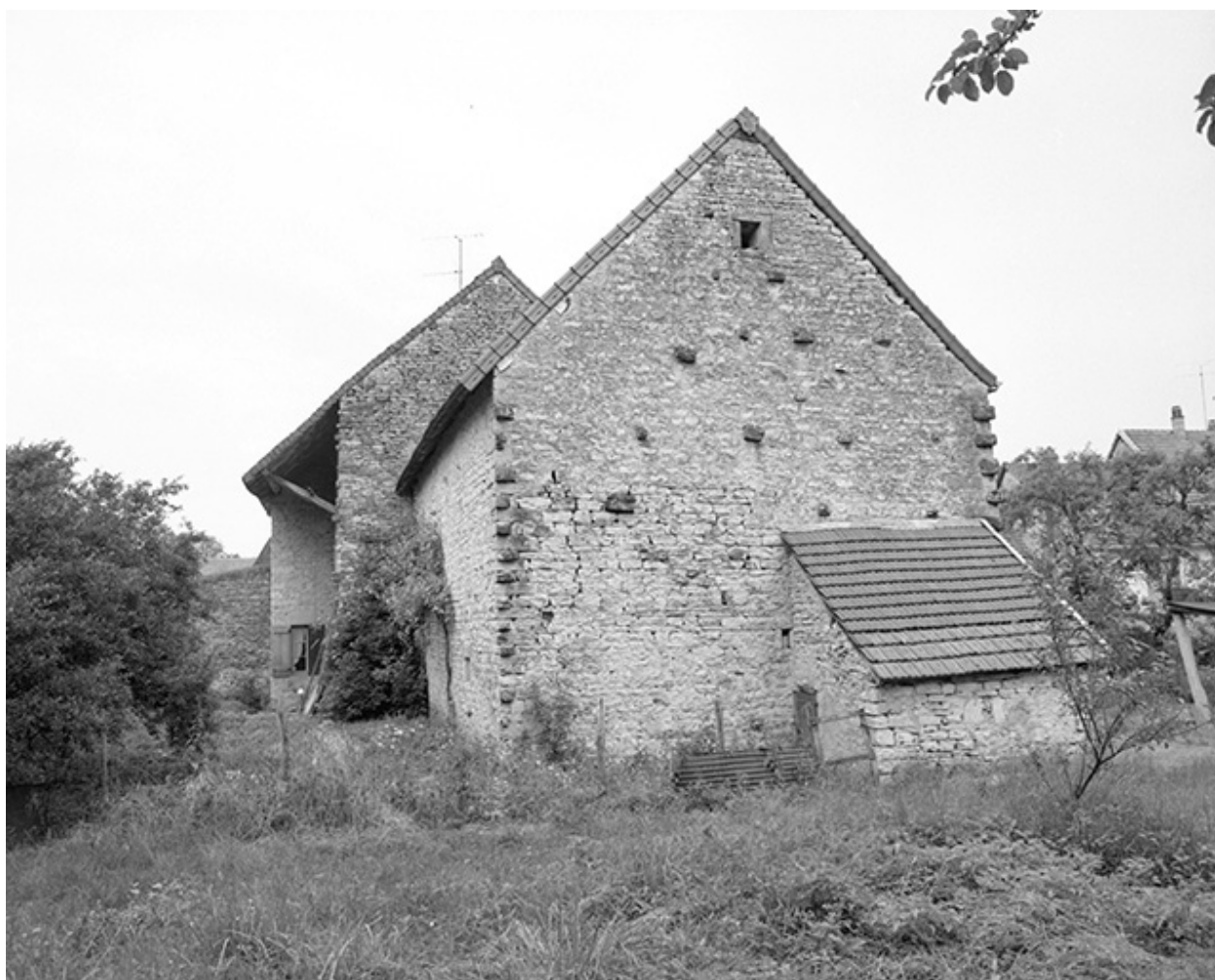
Ferme : façades postérieure et latérale gauche.
