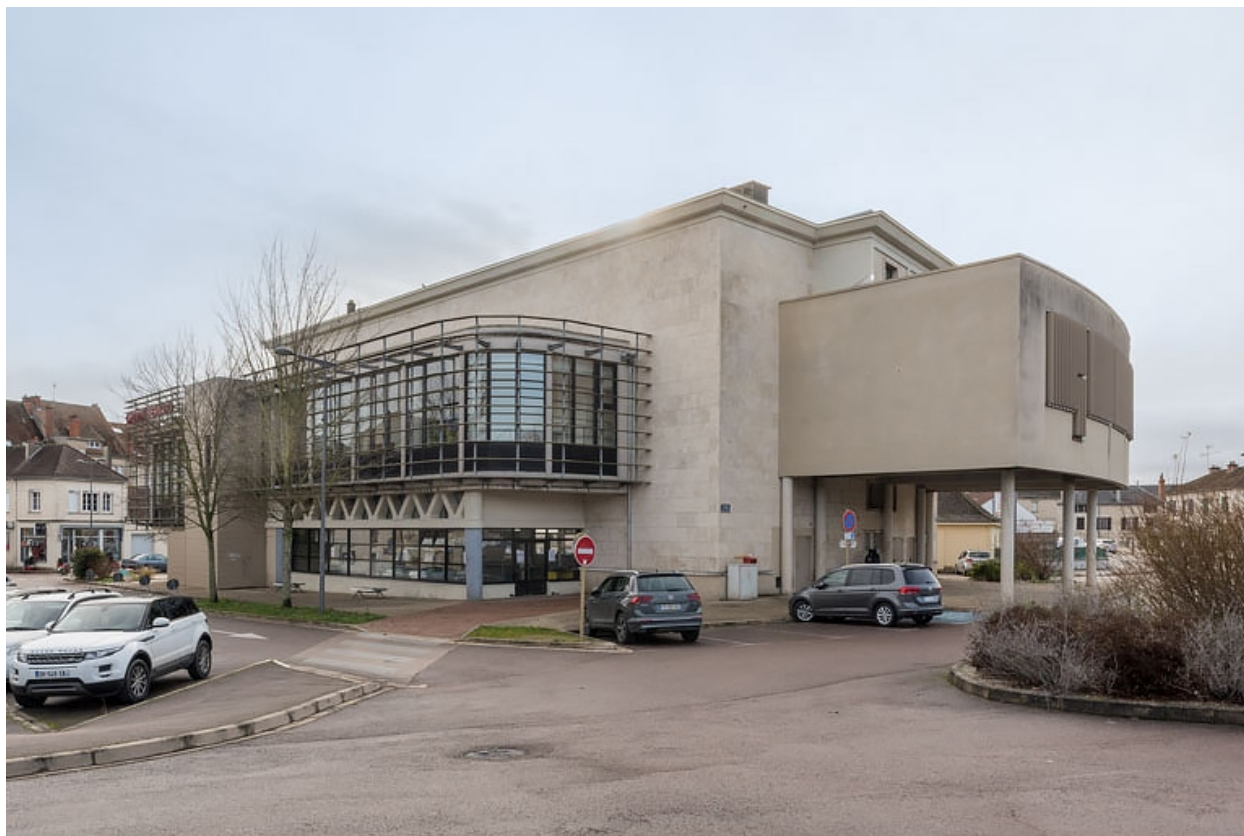
Façades postérieure et latérale gauche.
