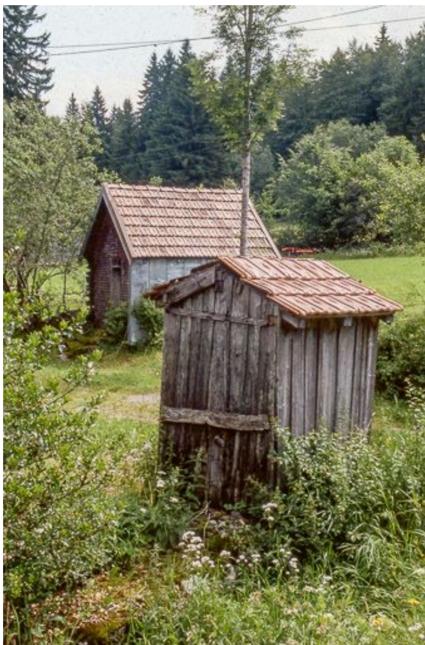
Resserre appelée "grenier fort", vue éloignée.
