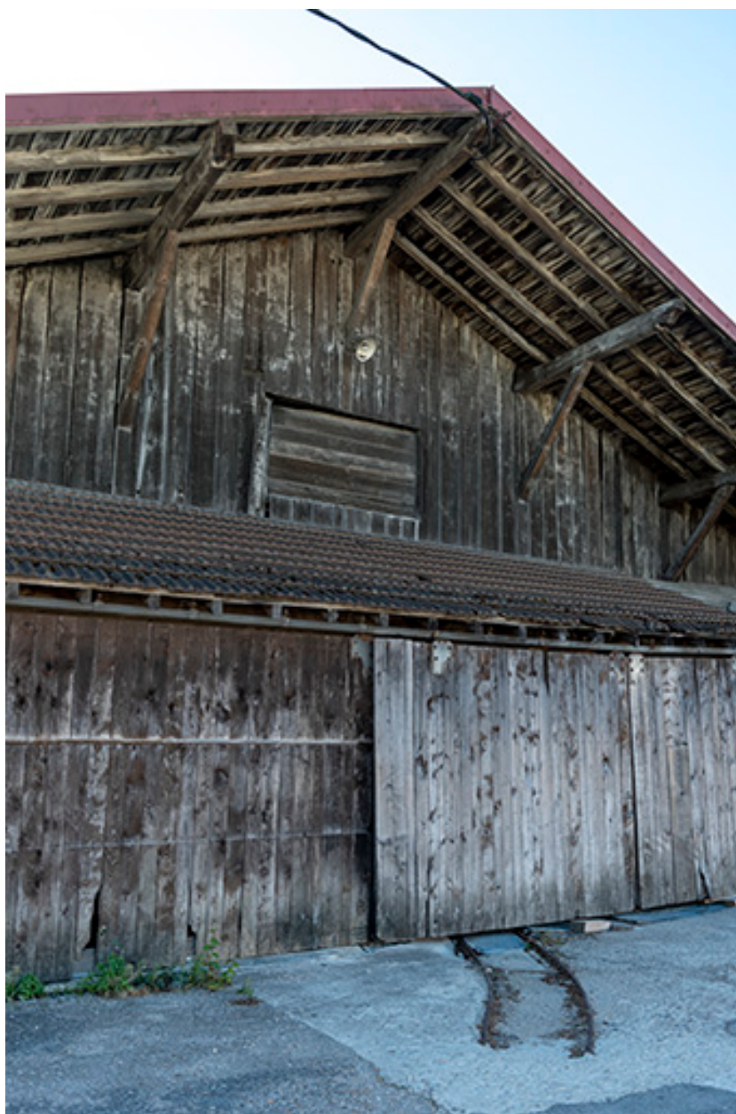
Atelier de 1919 : façade antérieure (nord).
