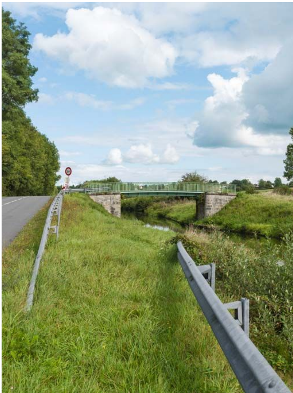
Vue d'ensemble du pont.
