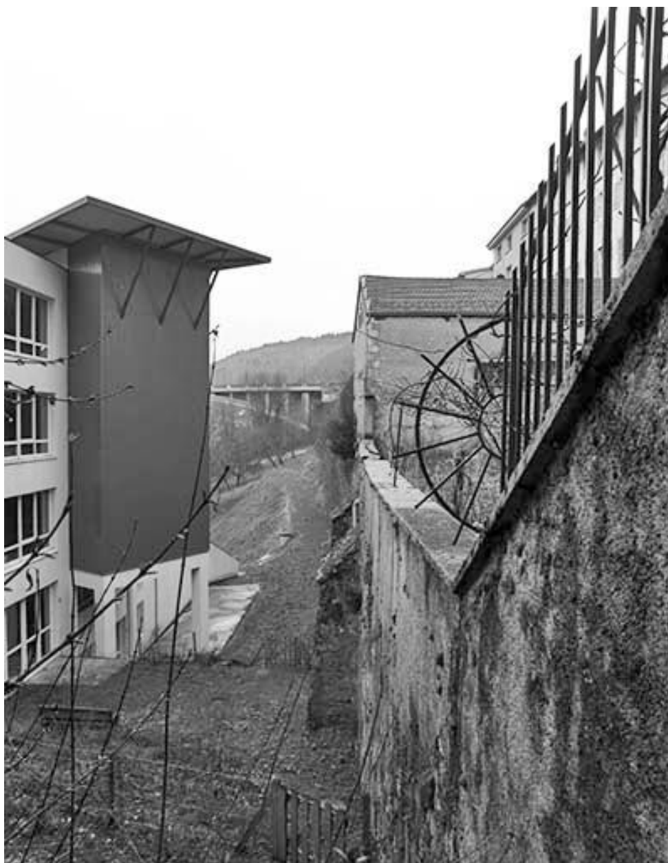
Mur sud de la clôture.
