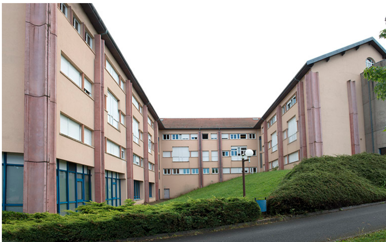
Détail de la façade sud-ouest de l'externat.
