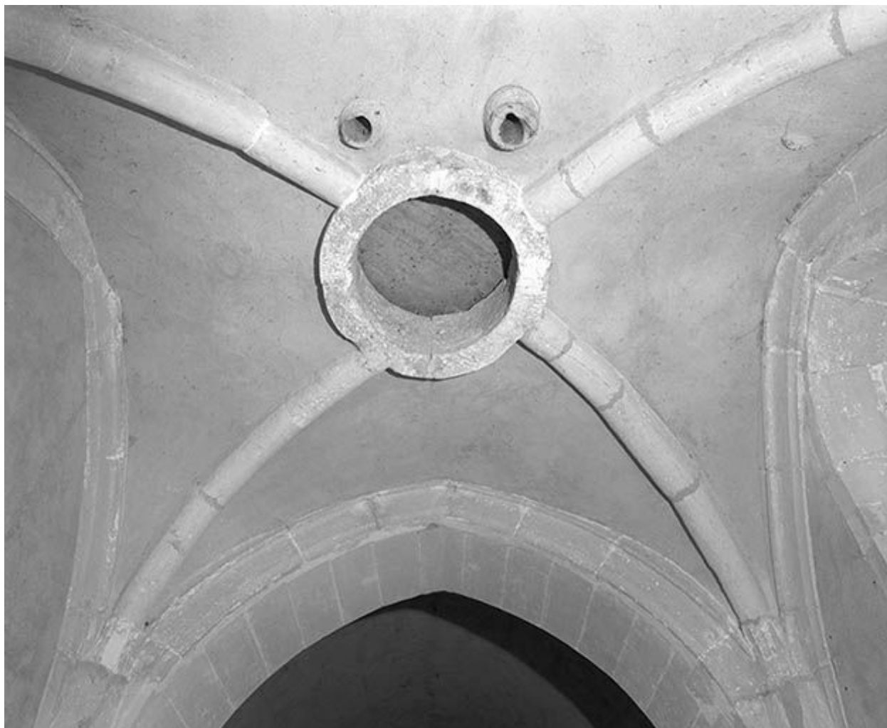
Voûte du vestibule.
