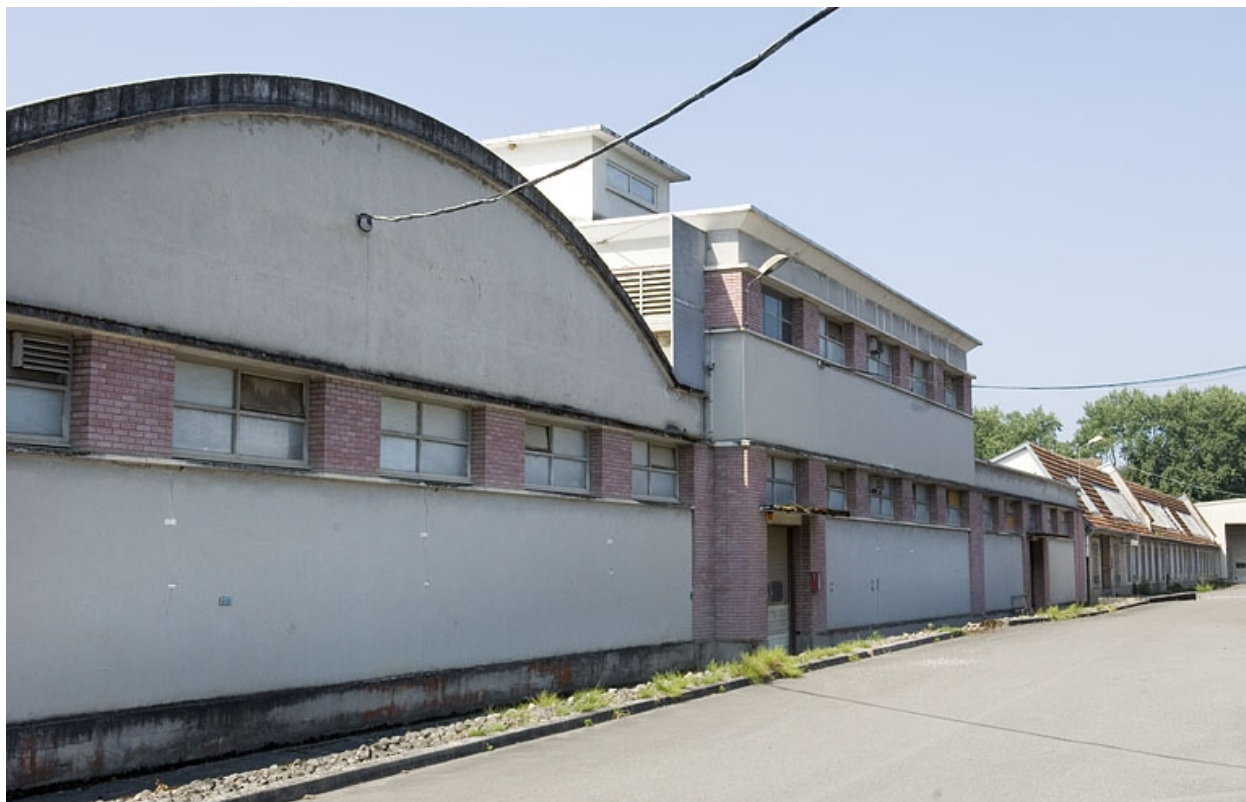
Façade nord de l'atelier de filature.
