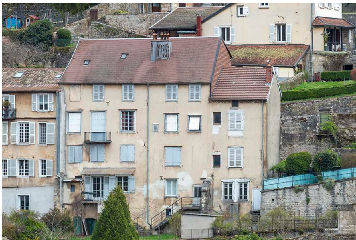
Vue d'ensemble depuis l'ouest.
