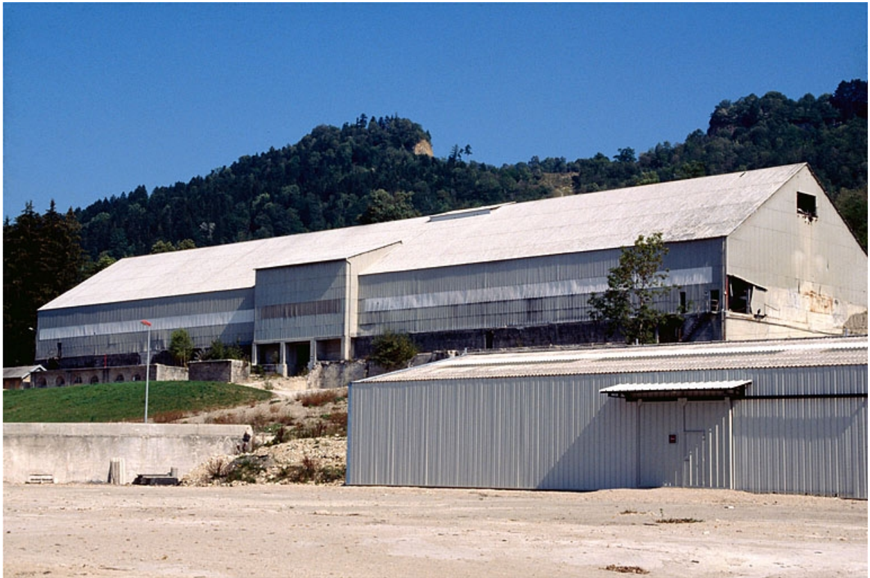
Usine de chaux et ciment Bouvet Ponsar et Cie, Champagnole : hall de préhomogénéisation.
