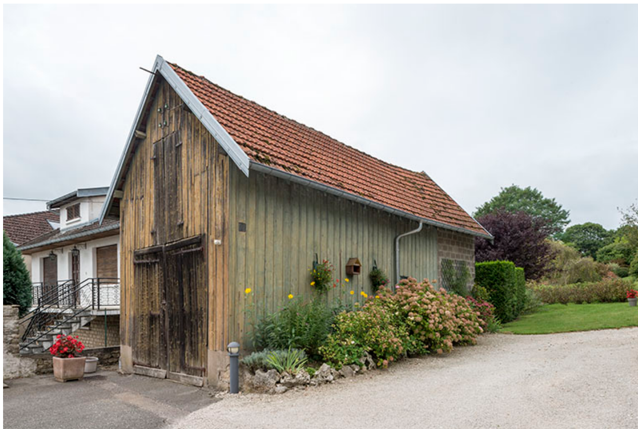
Le bâtiment à usage de garage.
