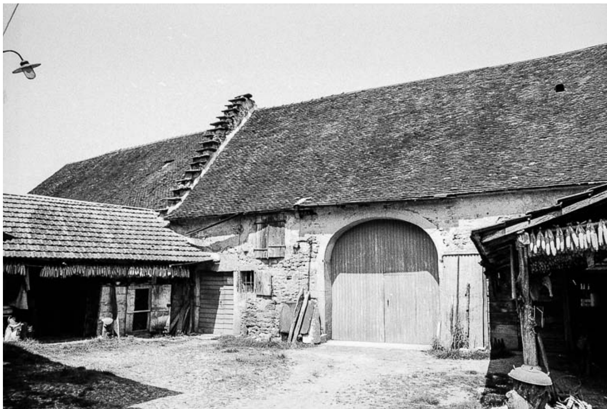
Fermes situées 324-326 rue d'Oisenans : bâtiments d'exploitation.
