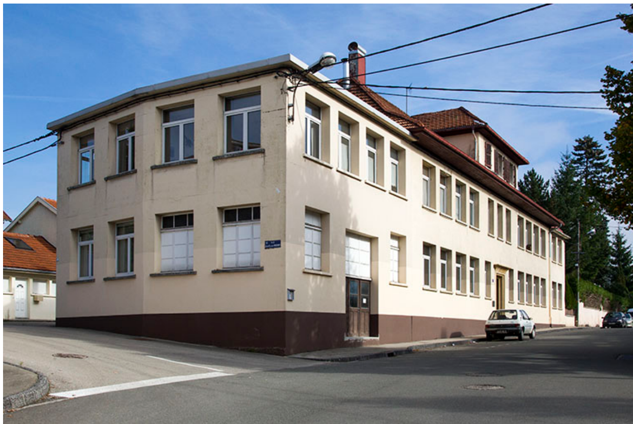
Usine : façade antérieure, de trois quarts gauche.
