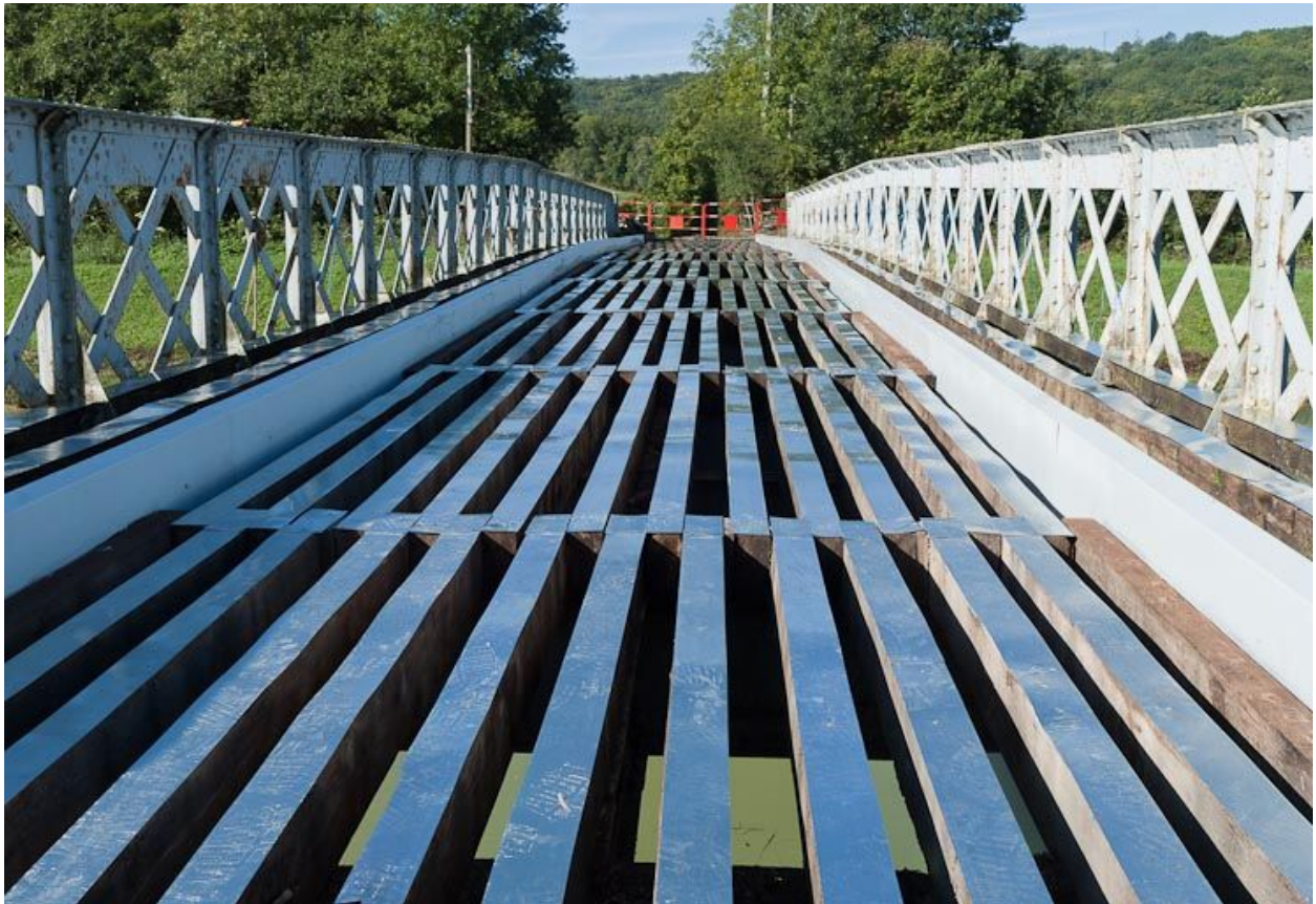
Vue du tablier pendant les travaux.
