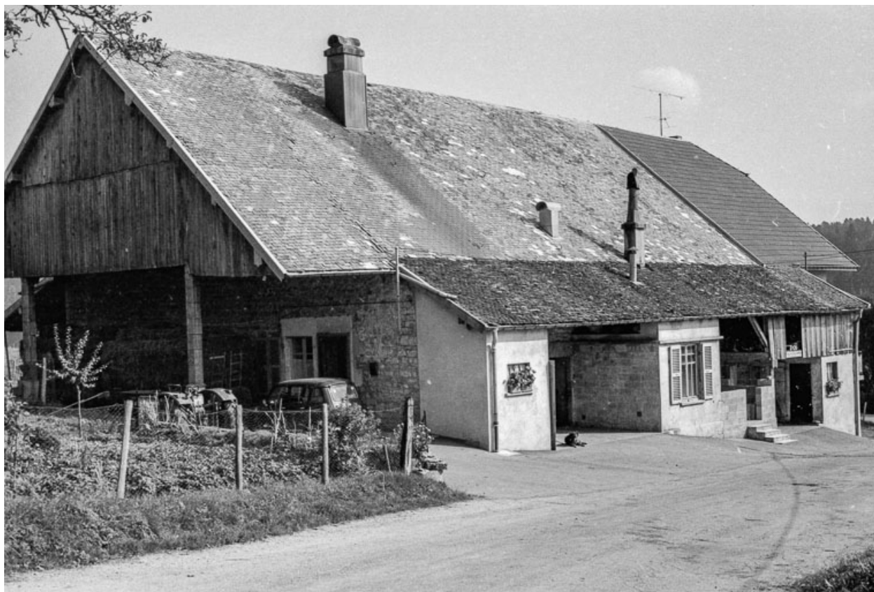
Ferme cadastrée 1961 AC 28 : façade sur rue.
