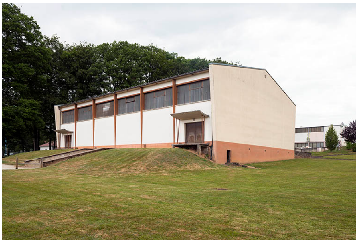
Gymnase : vue postérieure.
