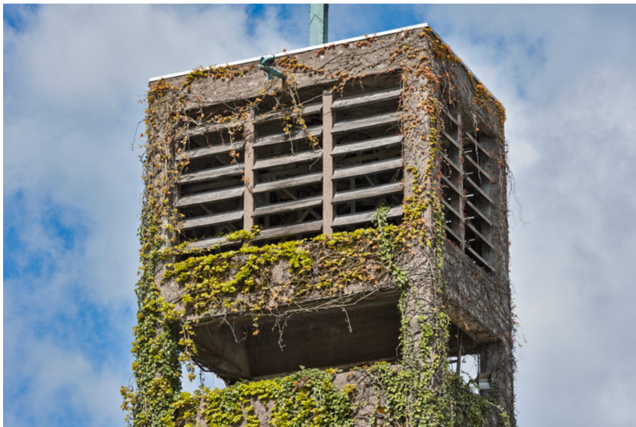
Clocher. Détail des abat-sons.
