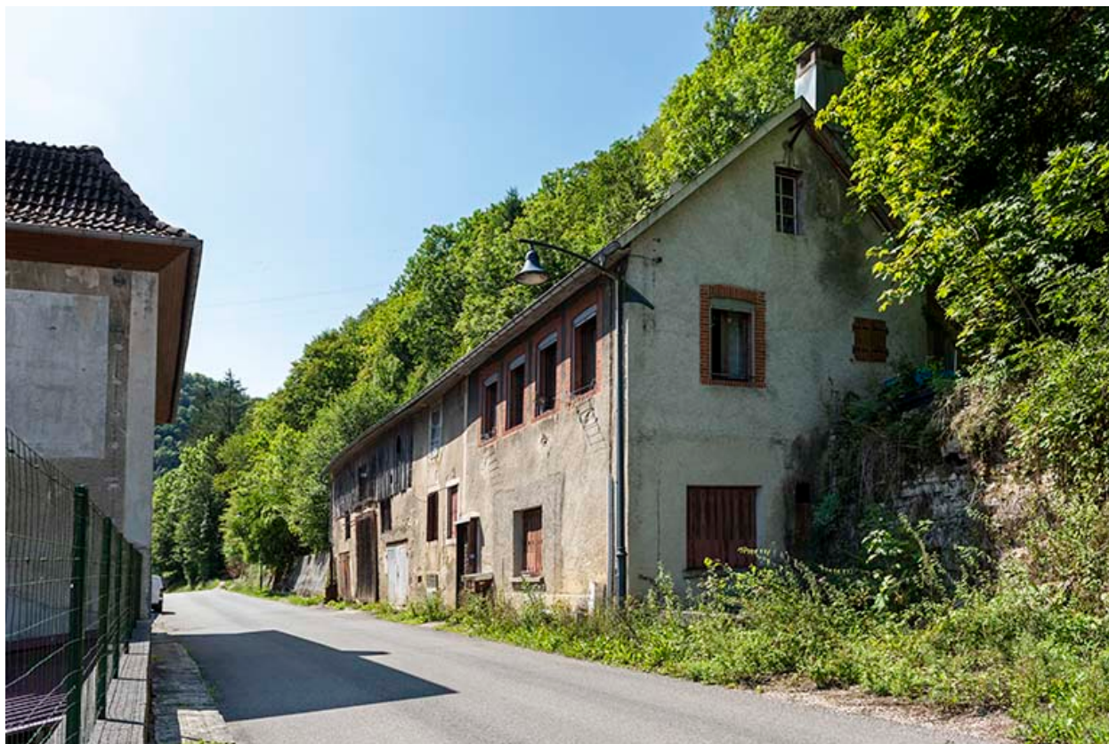
Logement occidental : vue d'ensemble, depuis le nord.
