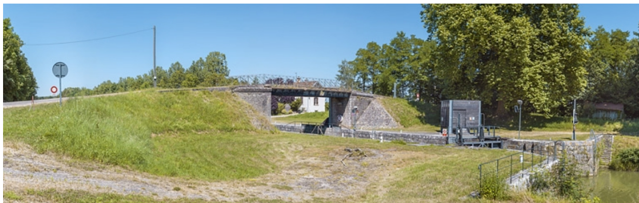
Vue d'ensemble du site d'écluse.
