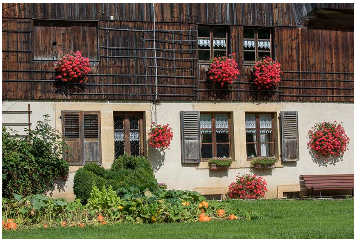
Ferme, façade antérieure : baies.
