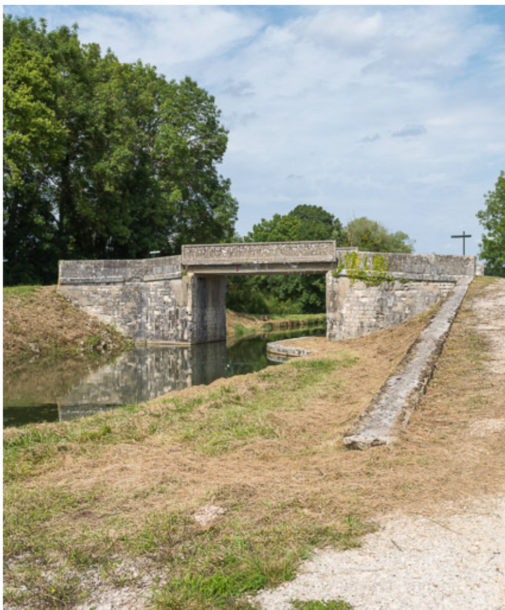
Vue du pont.
