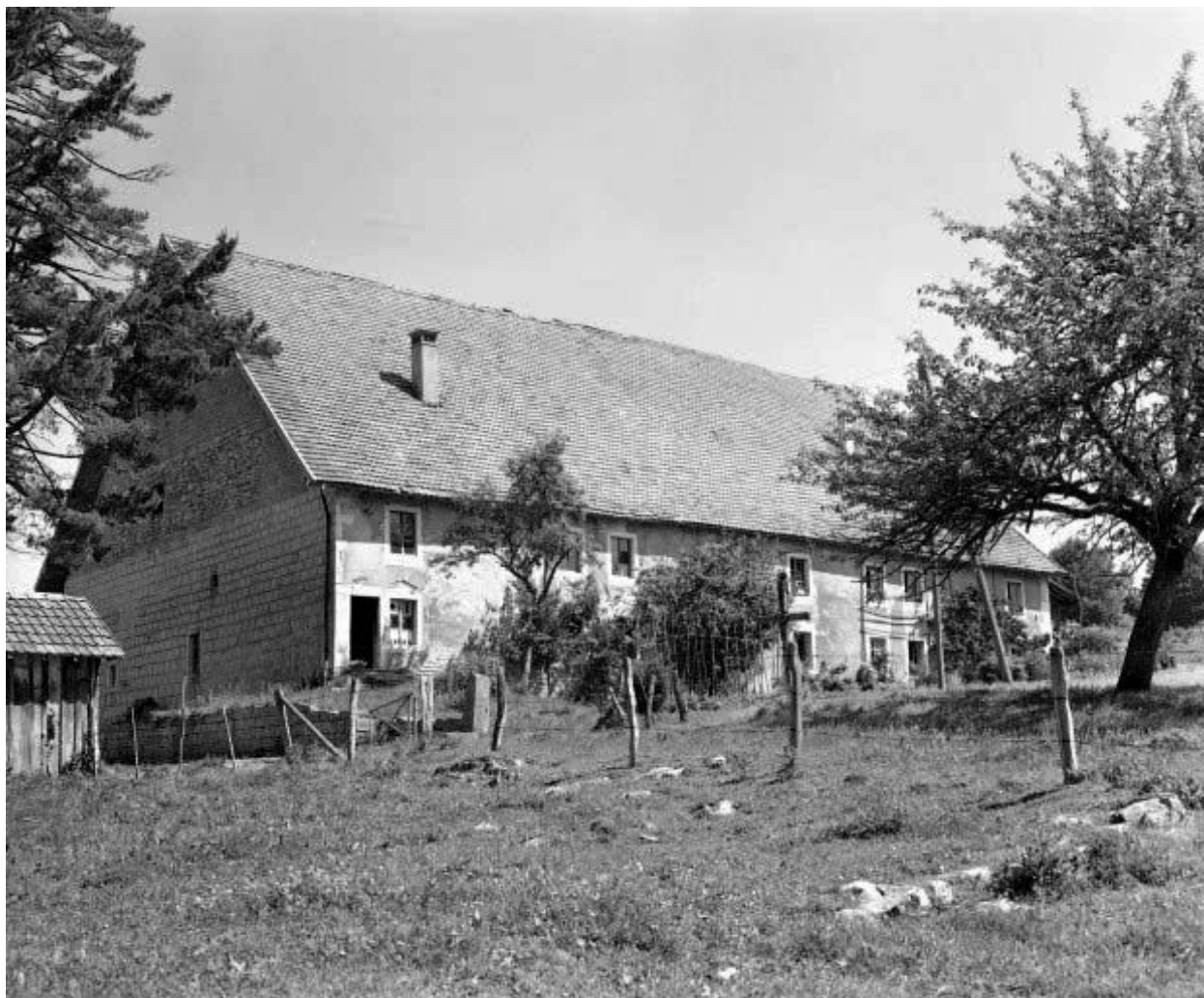
Façades antérieure et latérale gauche.
