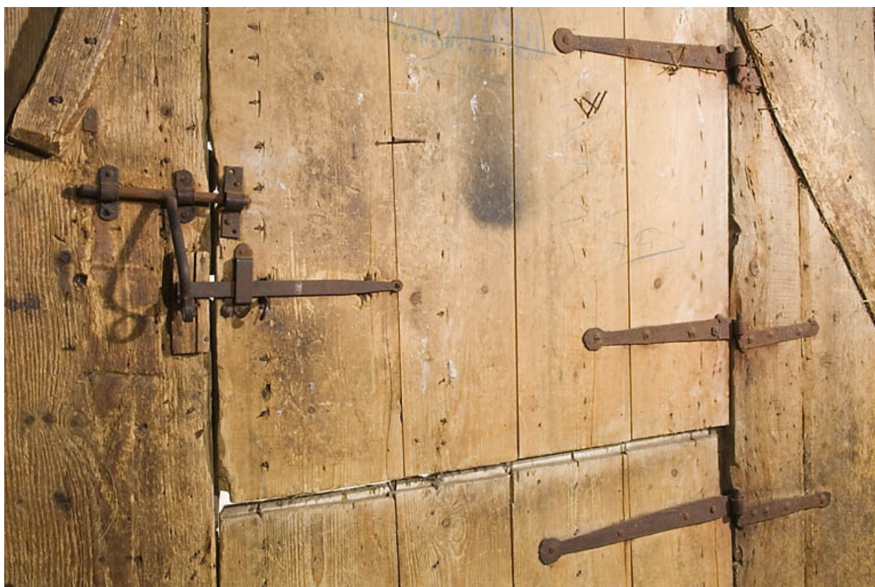
Façade antérieure, porte de grange : fermeture.
