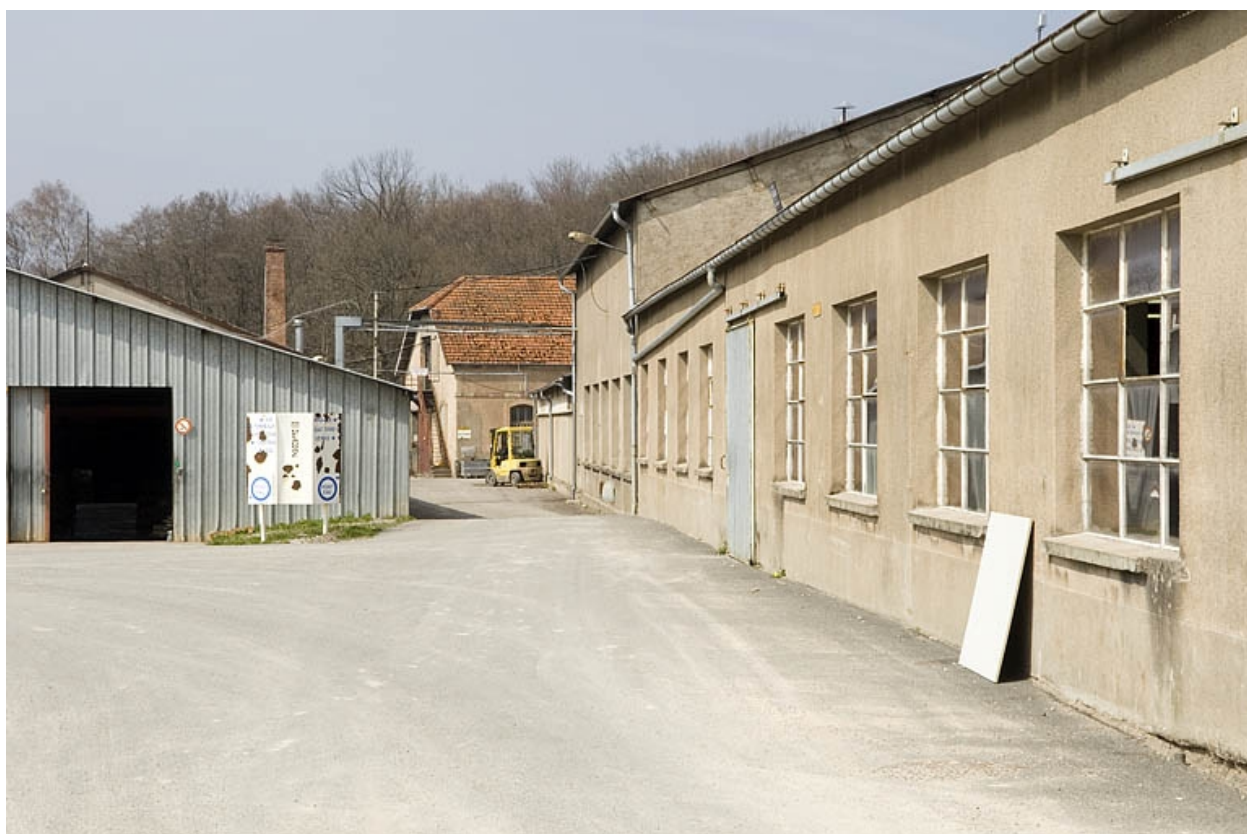
Façade ouest d'un atelier de menuiserie.
