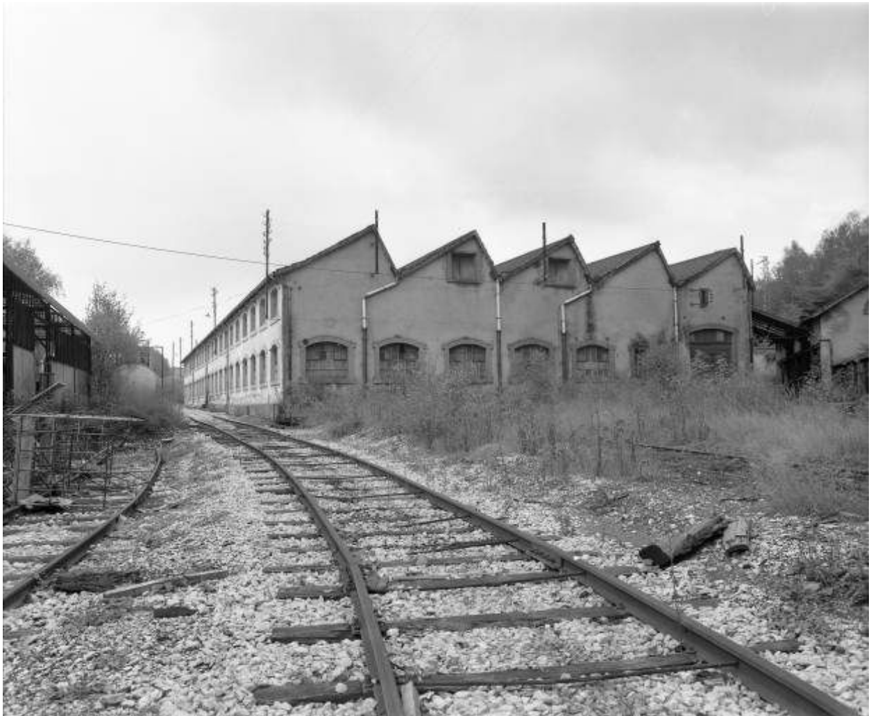
Atelier des pompes depuis l'ouest en 1981.
