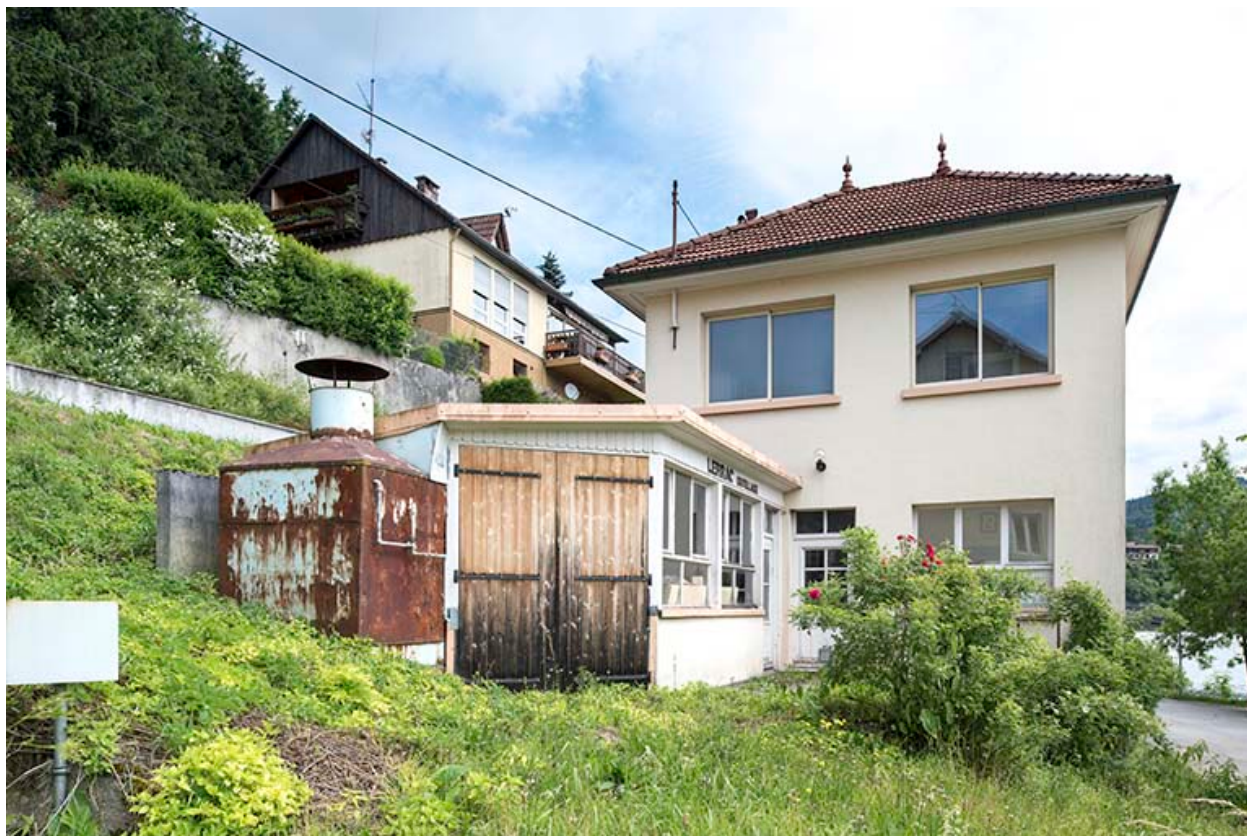
Façade latérale droite et atelier de peinture.
