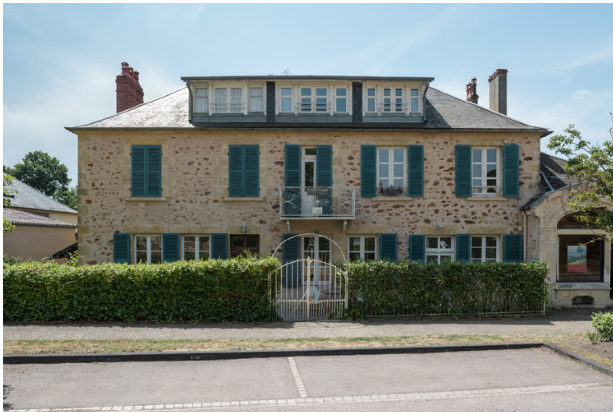
Façade actuelle sur l'avenue, vue de face.
