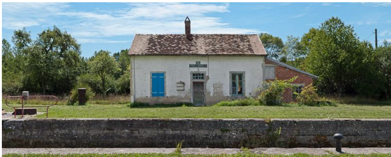
Vue de face de la maison éclusière.
