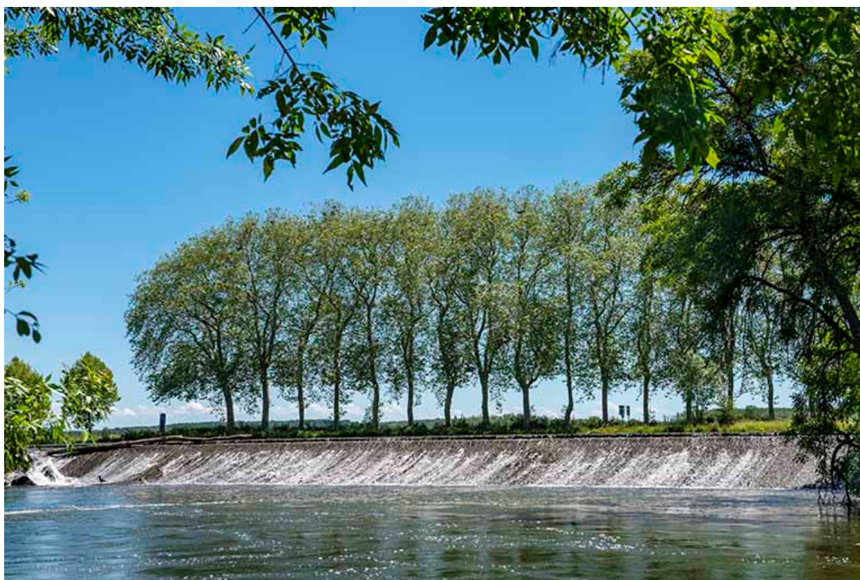
Déversoir en amont du barrage.
