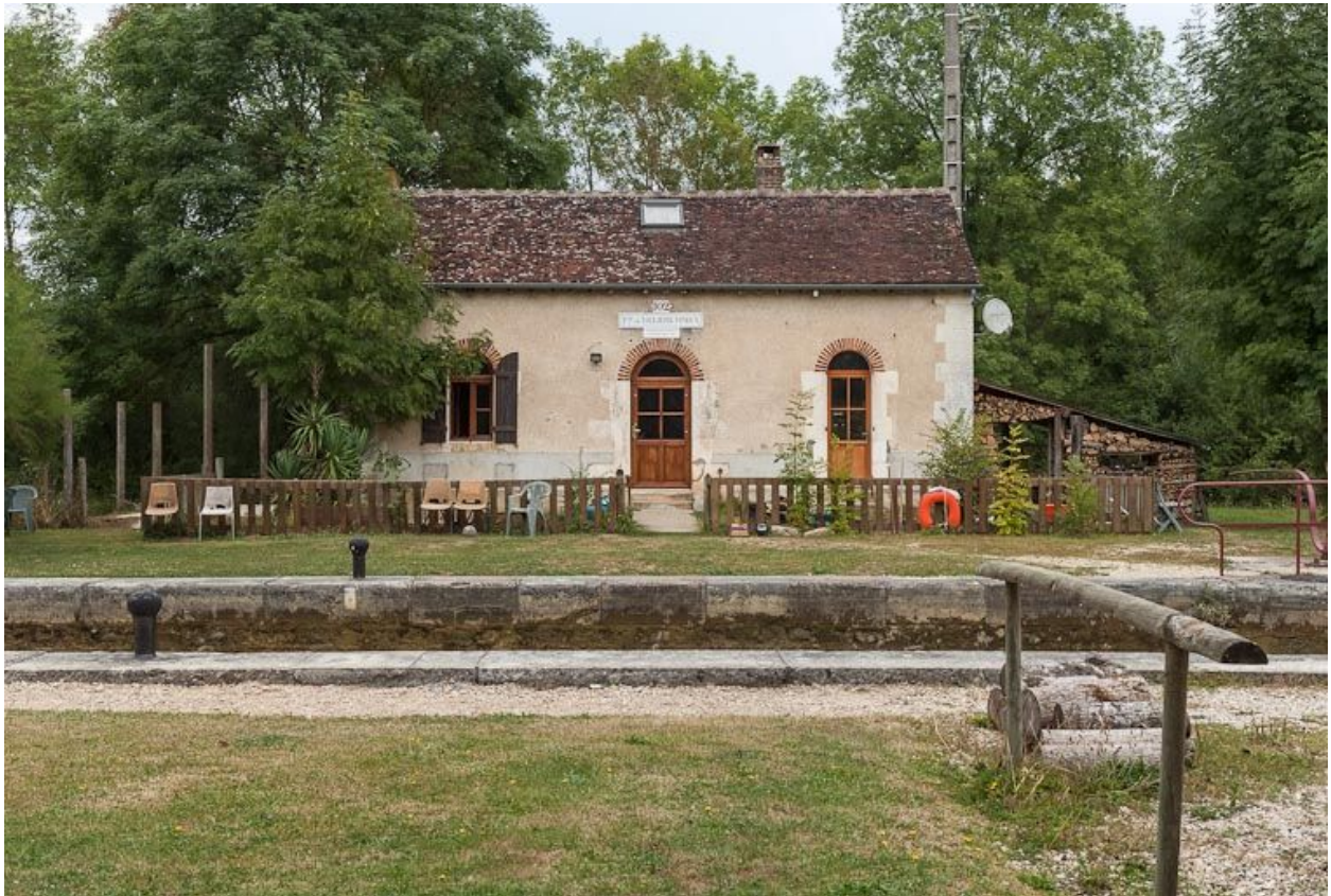
Maison éclusière de face.
