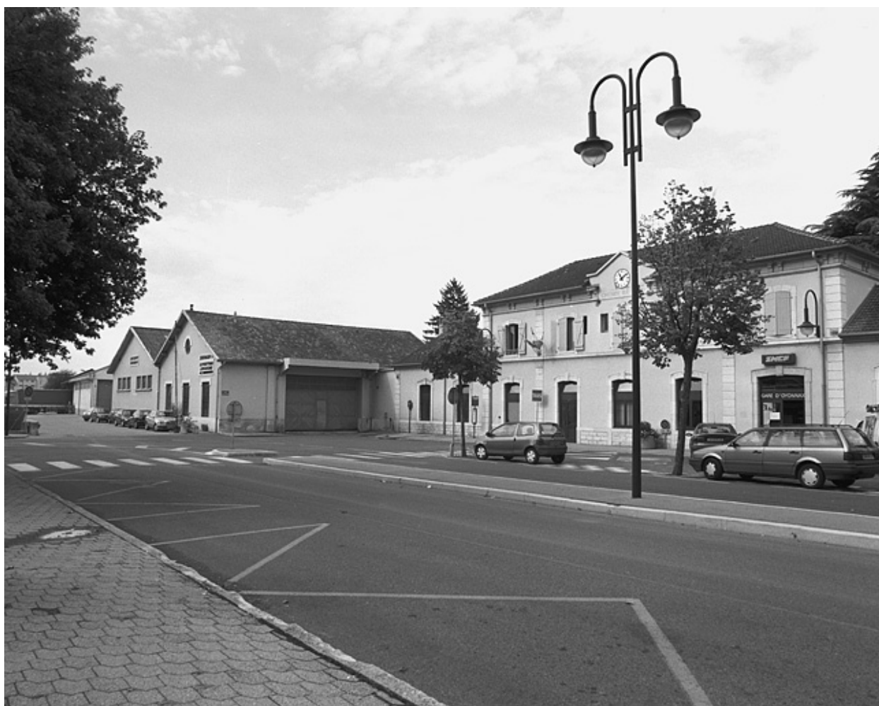
Entrepôts et cour, depuis le nord-est.
