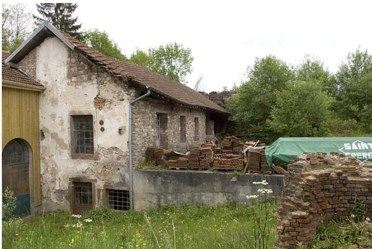
Atelier de réparation (forge et menuiserie).
