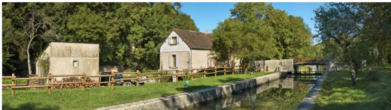
Vue d'ensemble du site écluse.
