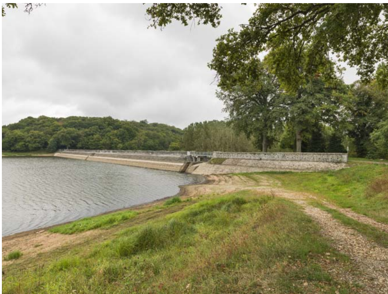
Vue de la digue.
