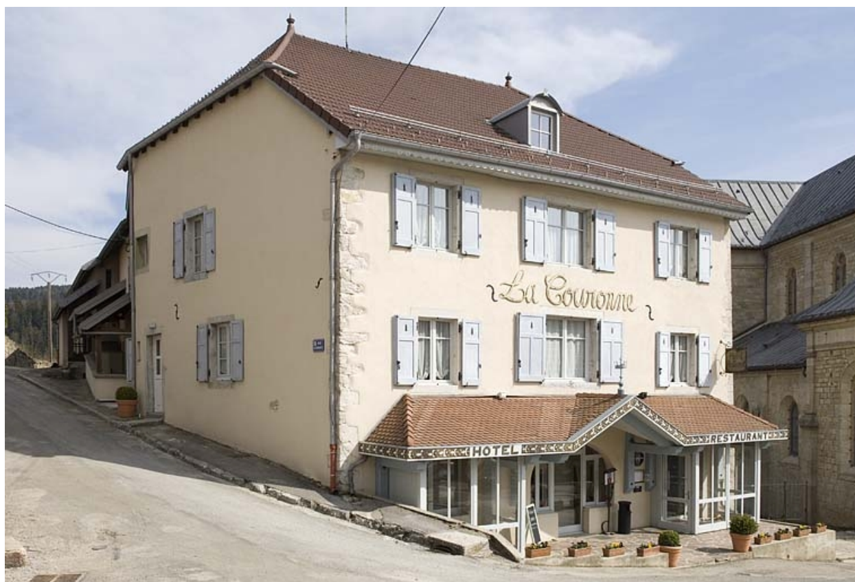
Façade antérieure et façade latérale gauche.
