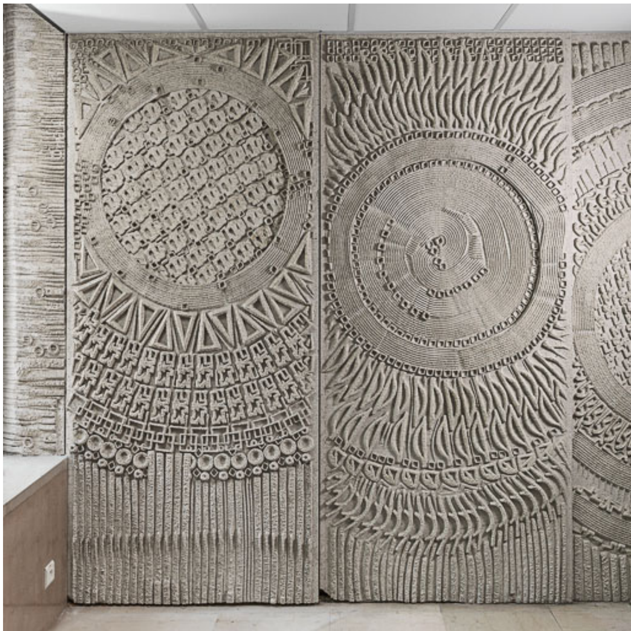
Hall d'accueil : panneaux moulés de la mezzanine.
