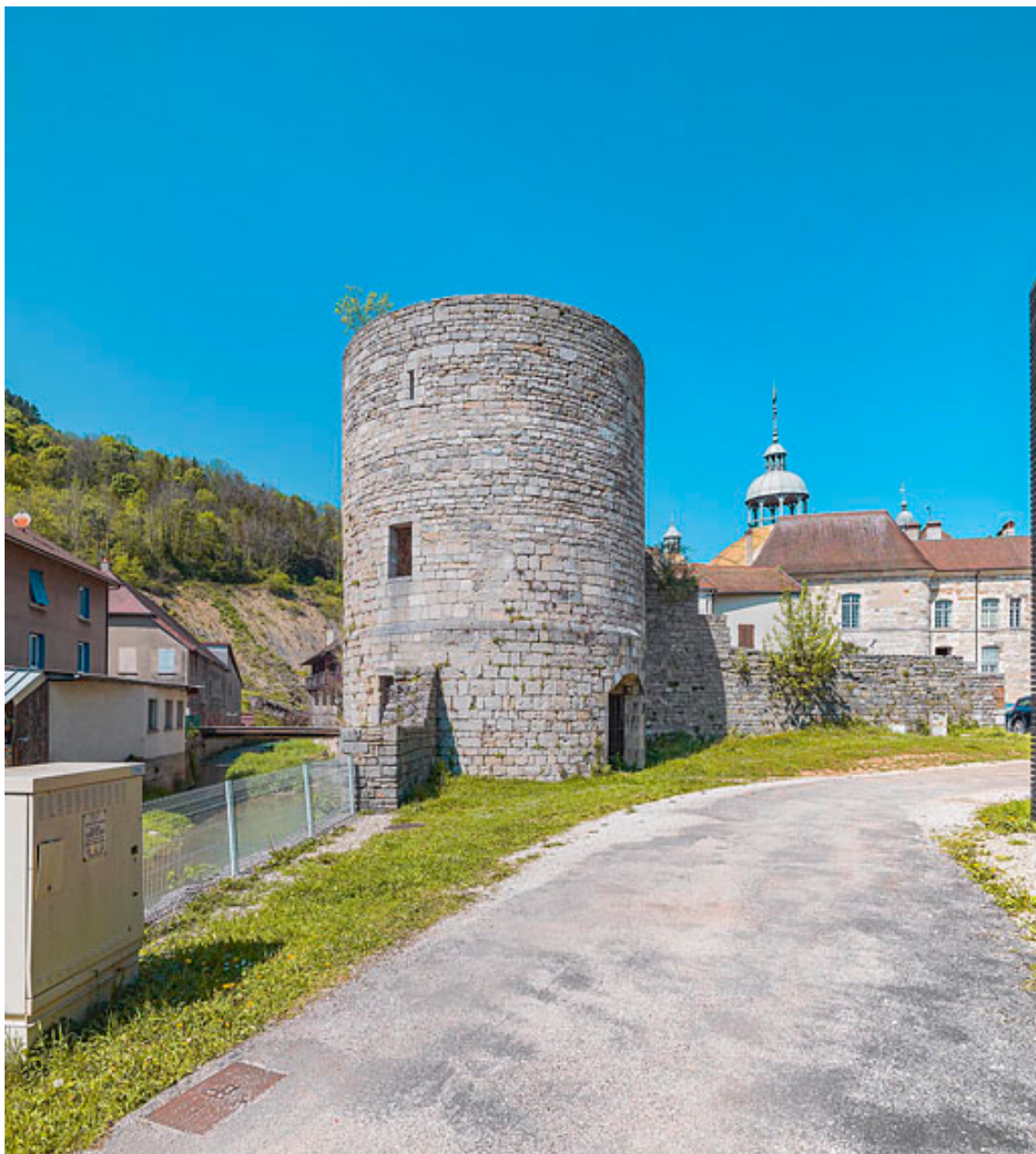
Vue depuis le sud.
