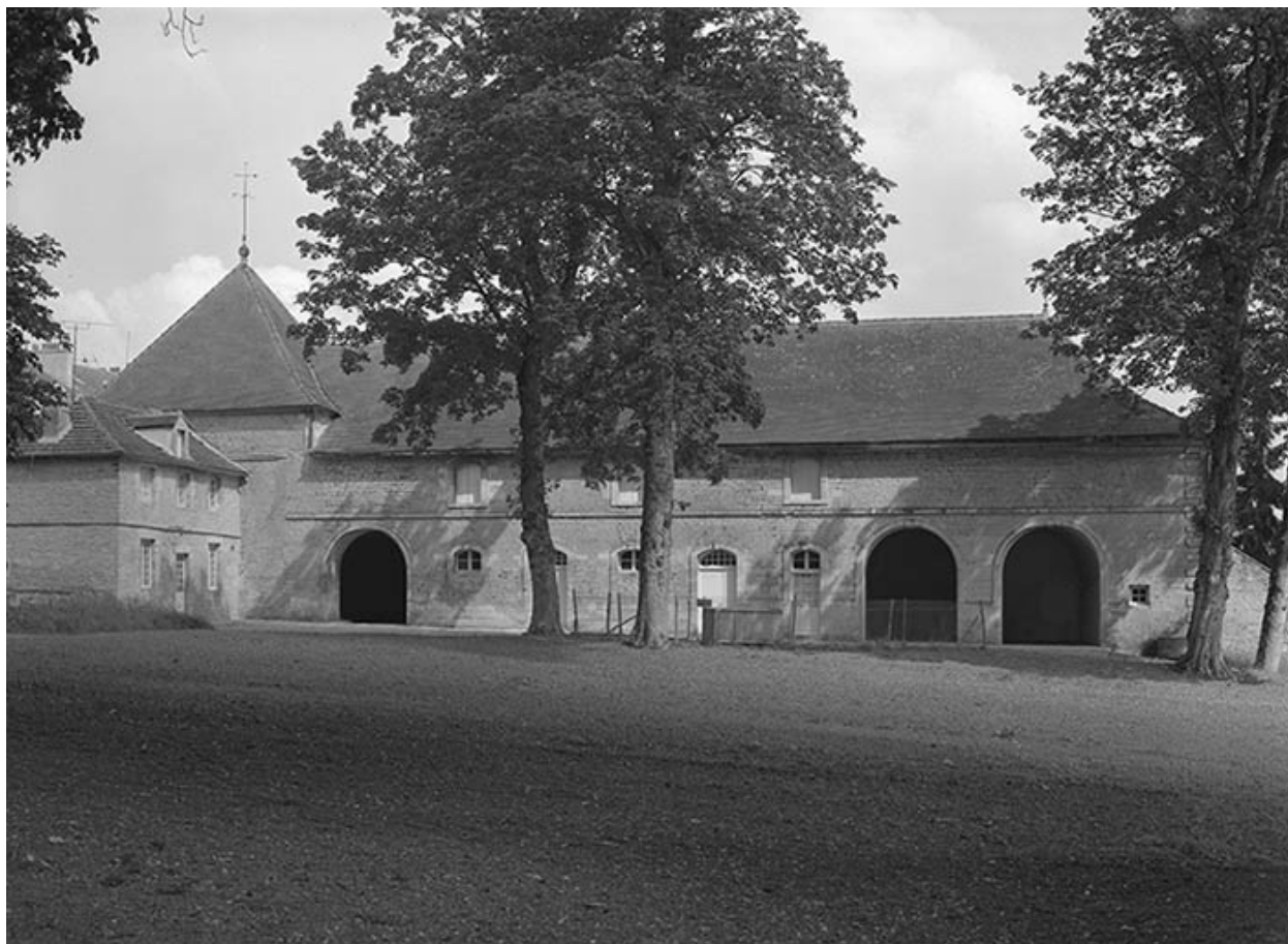
Bâtiment de communs.
