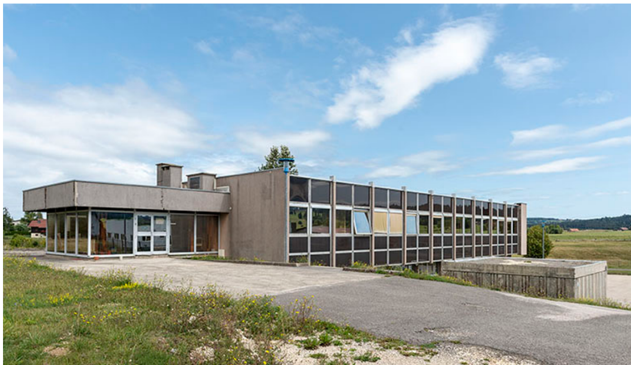
Façades antérieure et latérale gauche.
