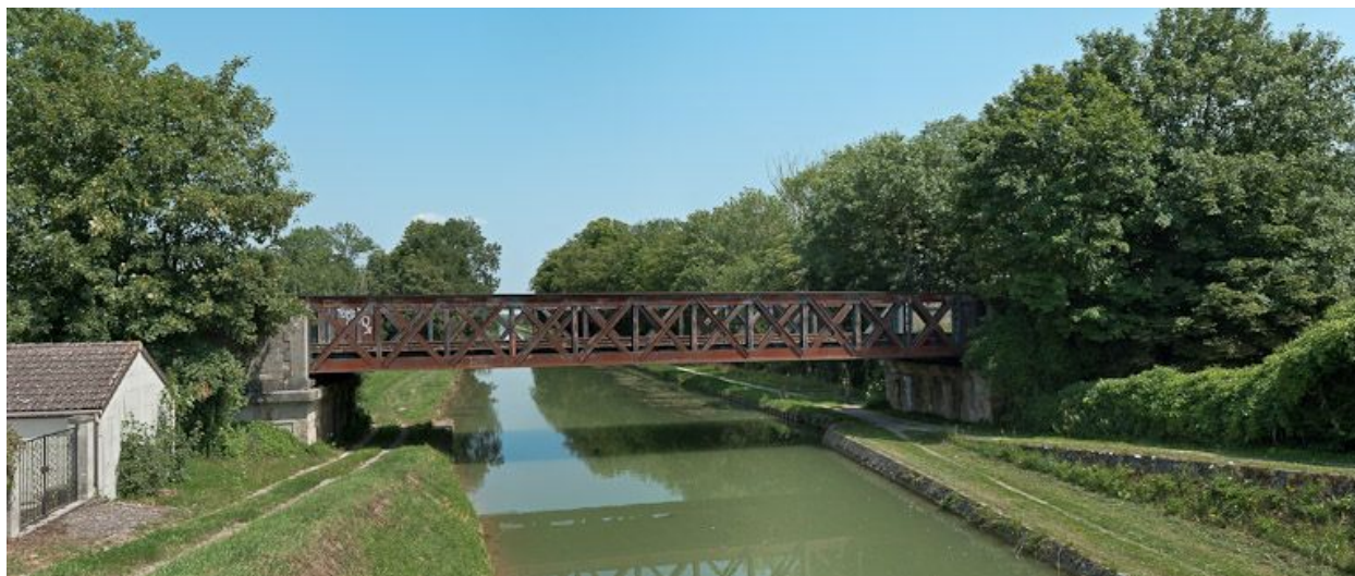
Pont ferroviaire isolé à Saint-Florentin.
