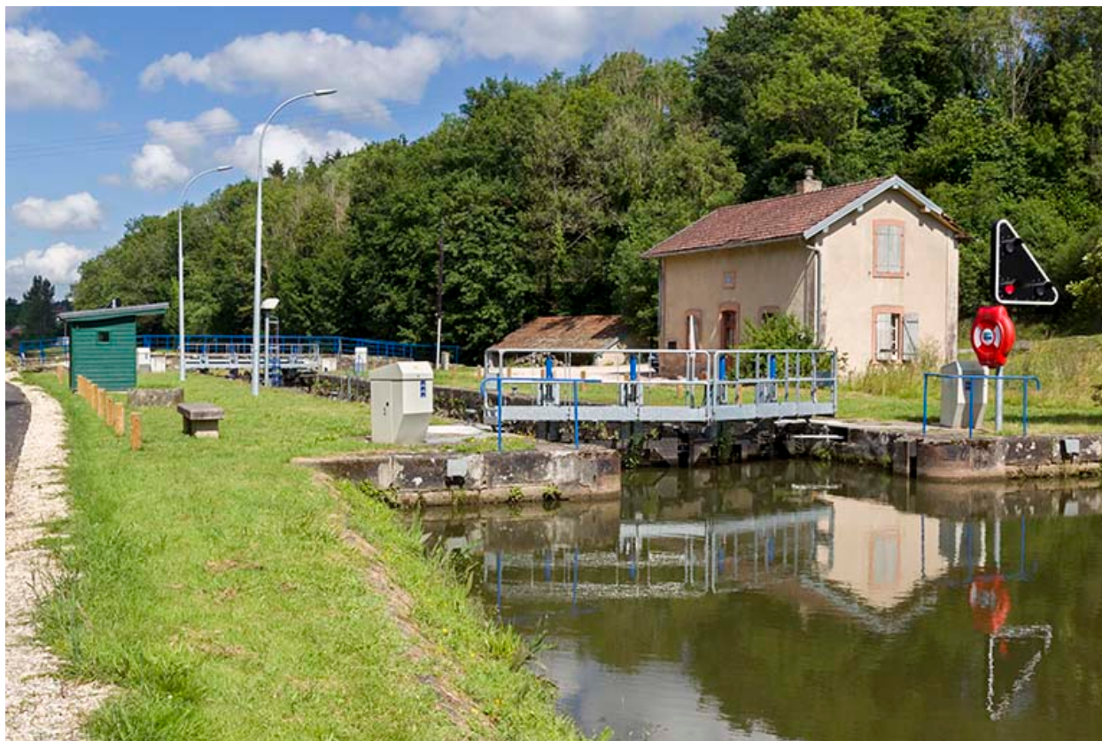
Le site d'écluse, depuis l'amont.
