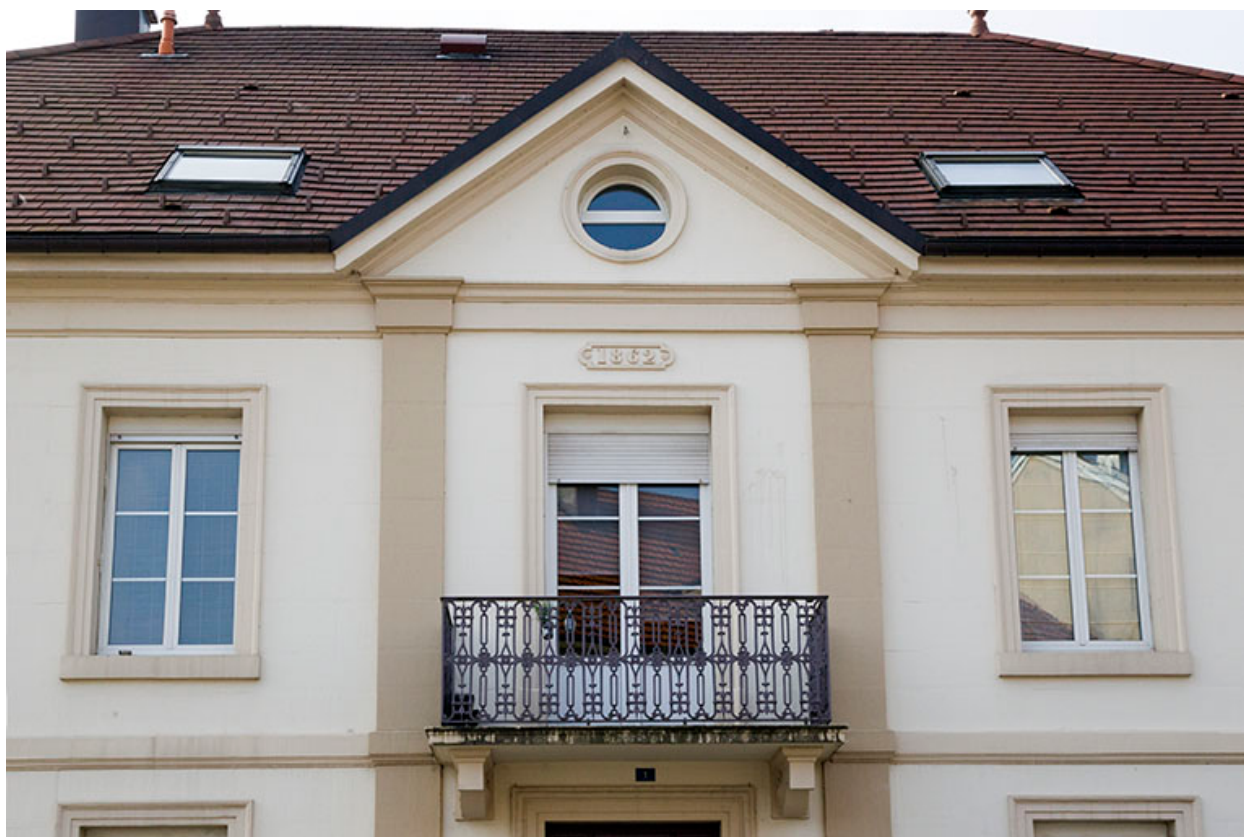
Façade antérieure : premier étage.
