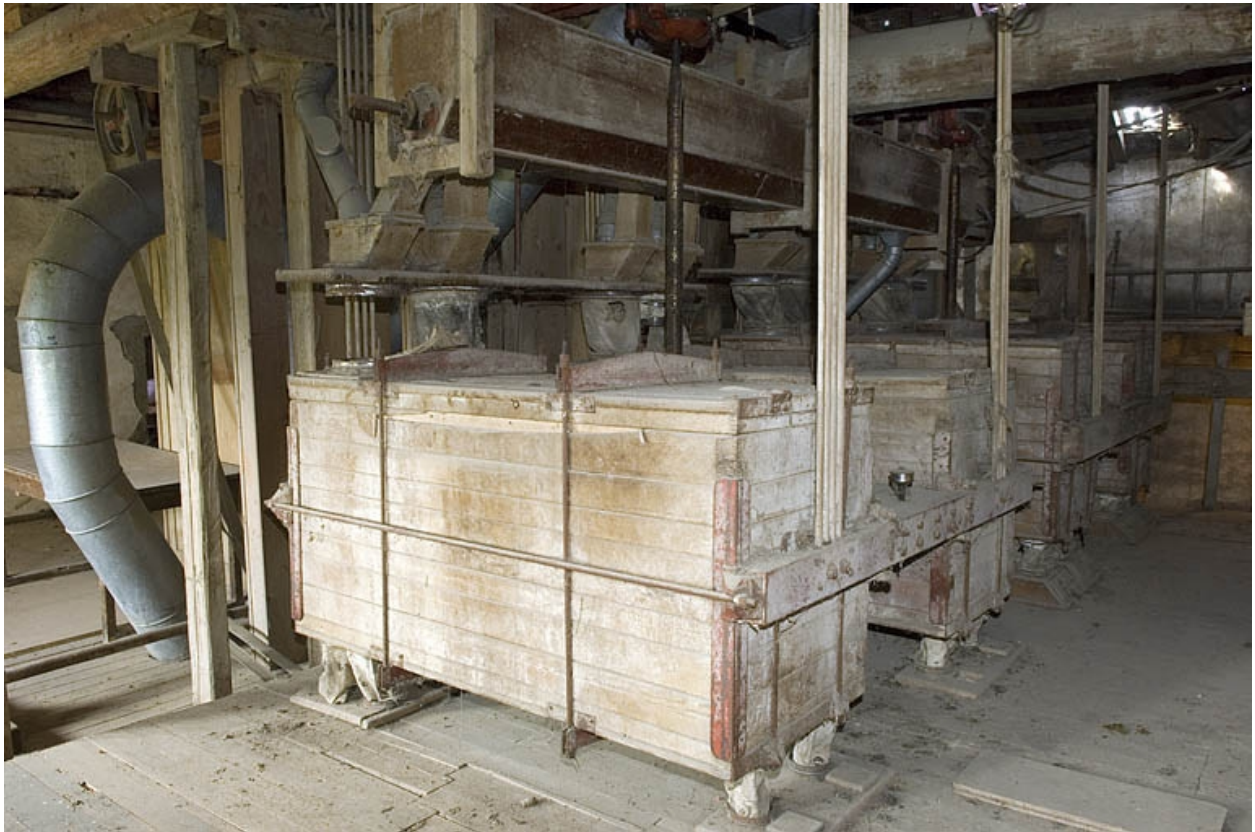
Vue d'ensemble des plansichters (3e étage).
