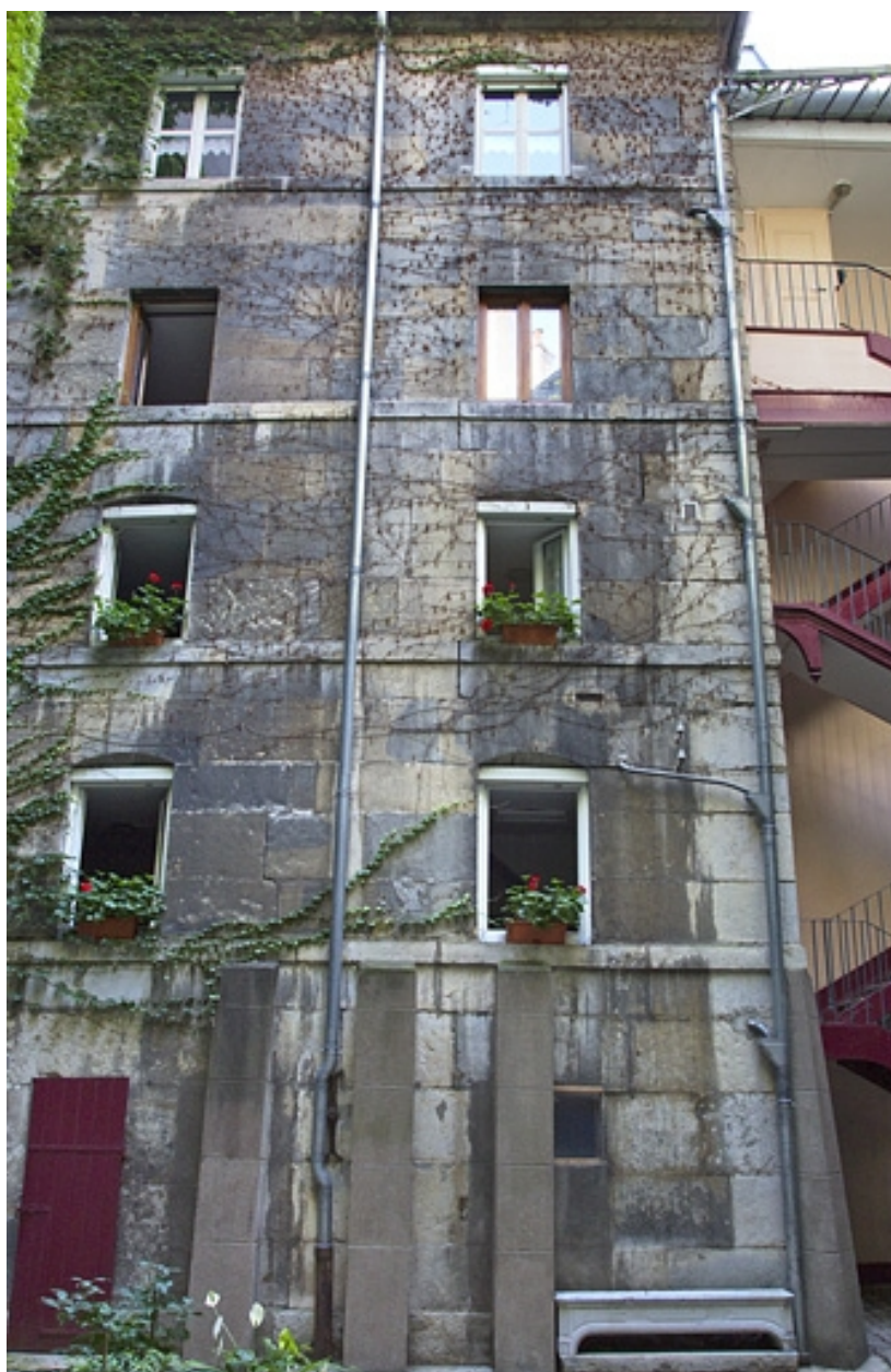
Vue d'ensemble du logis secondaire, de face.
