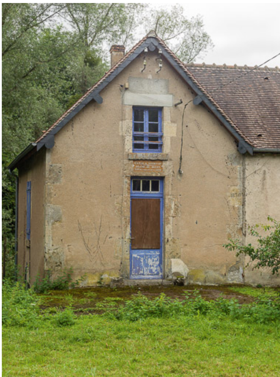
Vue de la maison éclésièr.
