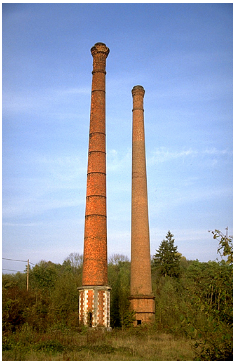
Cheminées d'usine, depuis le sud-ouest.
