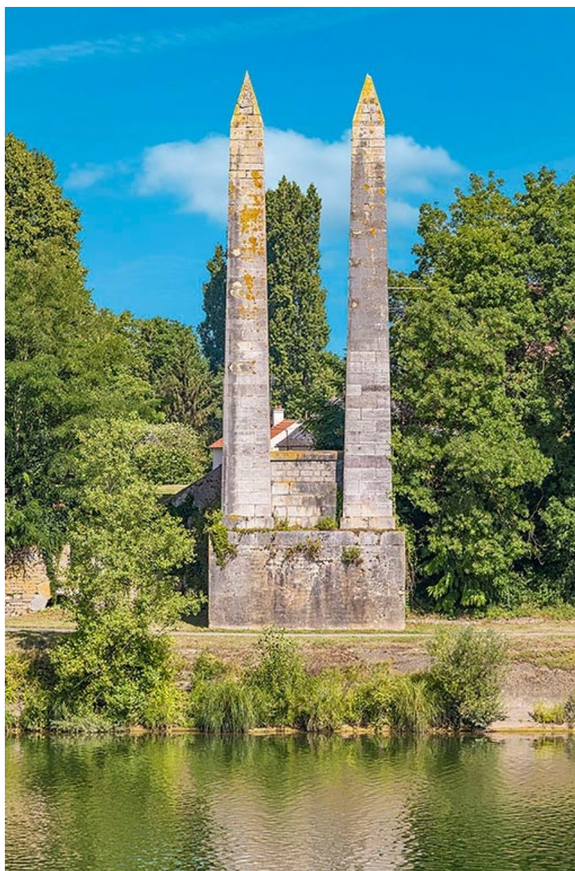
Pylônes de la rive droite.
