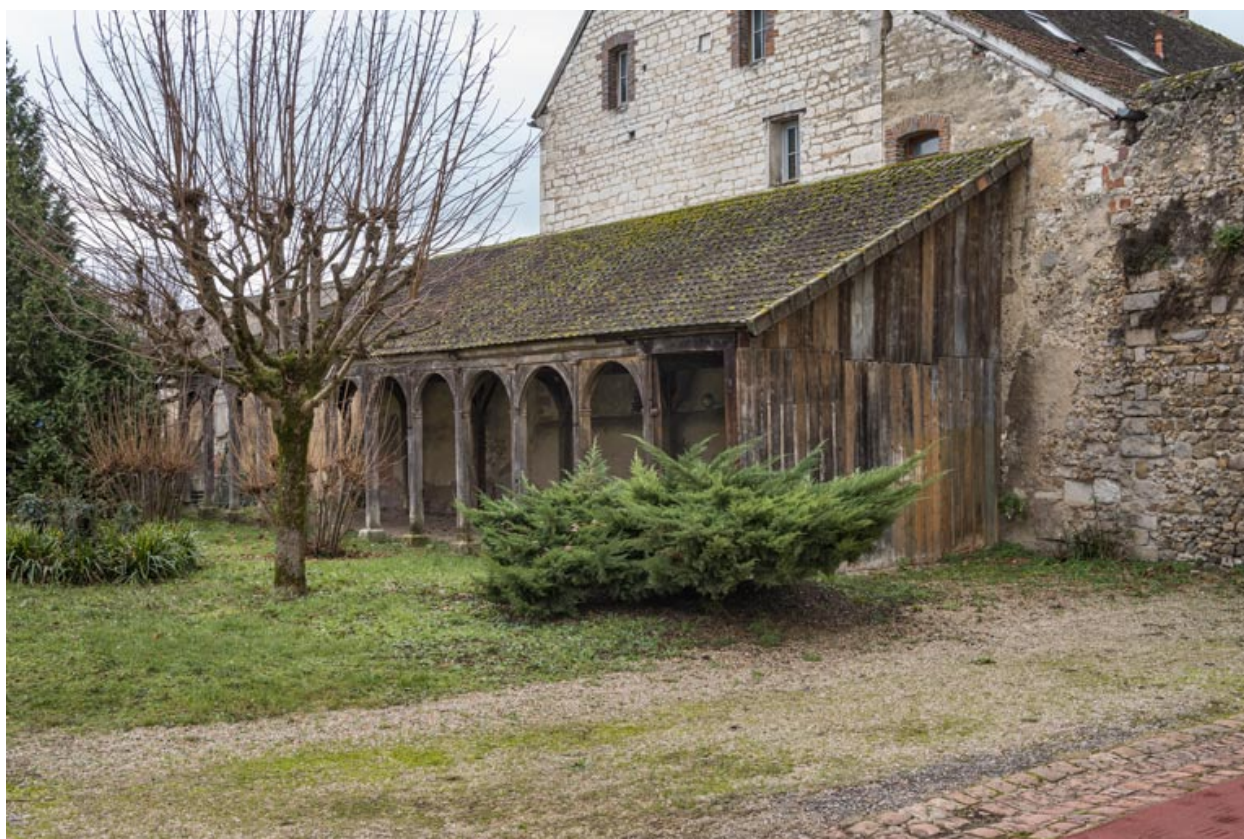
Ancienne halle de 1818-1819, de trois quarts droite.
