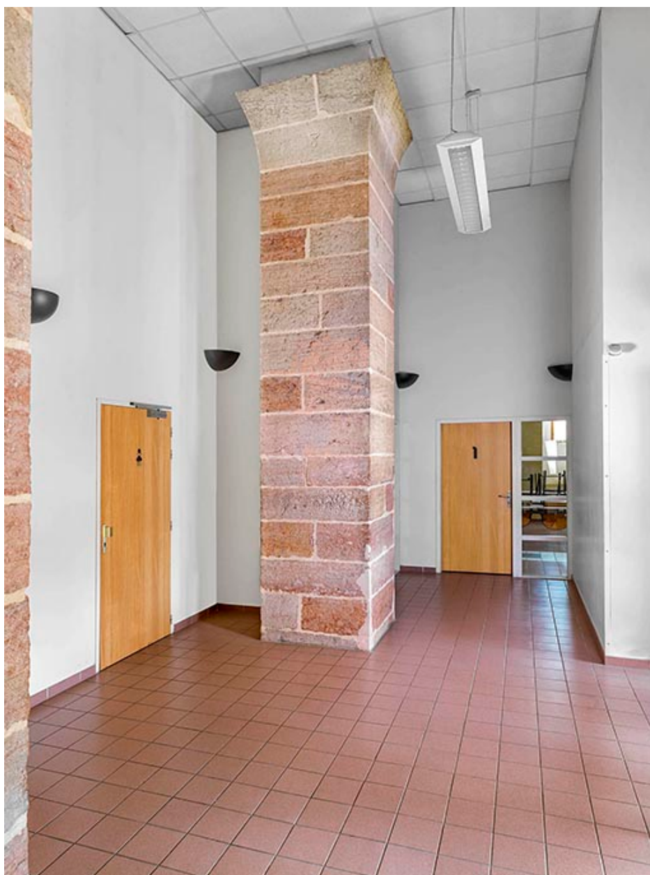
Détail d'un des piliers.
